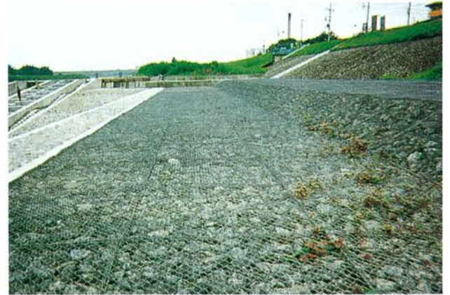
国土交通省関東地方整備局京浜河川事務所 四谷本宿堰魚道整備工事
