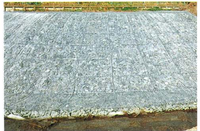
国土交通省関東地方整備局江戸川河川事務所 地金堀樋管新設及び築堤護岸工事
