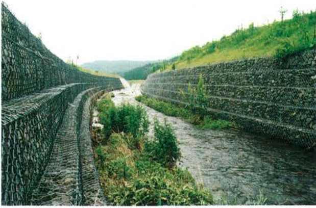
宮城県名取市役所 大沢川災害関連工事
